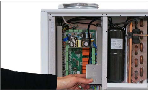
7. Den Stromversorgungsbox wird bei der Steuerung montiert (2 Löcher soll gebohrt werden).
